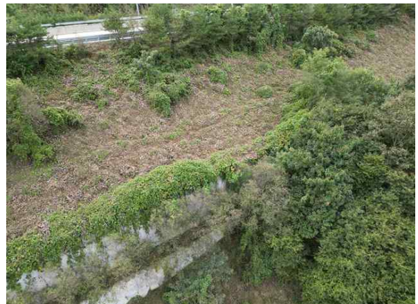
상부 성토부 전경
