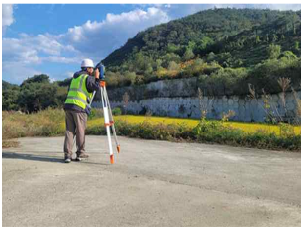
광파기를 이용한 측량 작업
