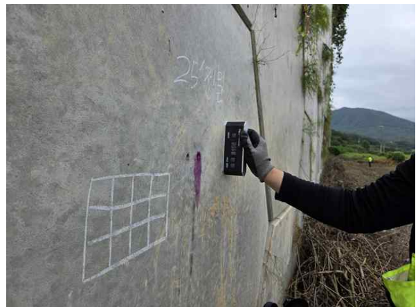
경사계를 이용한 경사도 측정
